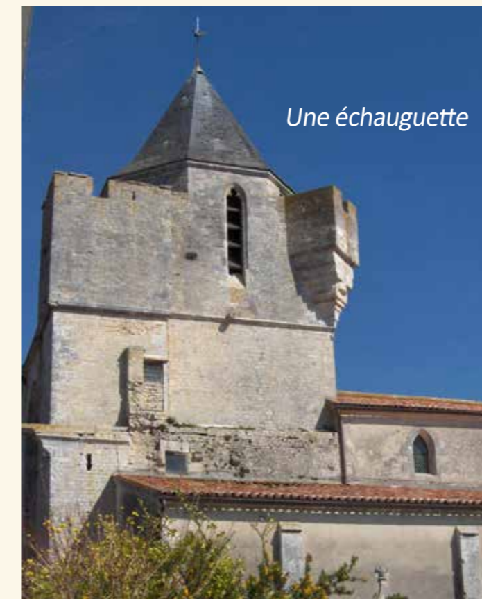
Cette petite tourelle placée en encorbellement à l'angle du clocher est un élément de fortification nommée échauguette. Dotée de créneaux et d'ouvertures de tir, elle permettait de surveiller et protéger les abords.
